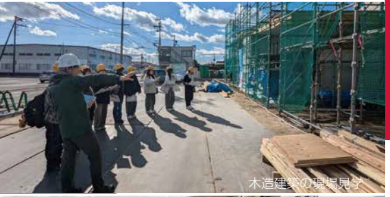
木造建築の現場見学
