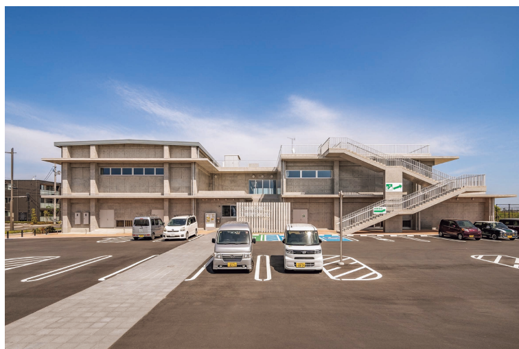
図25 アプローチにはゆるい勾配を設定し、段差を解消しつつ、安全な床高を確保
