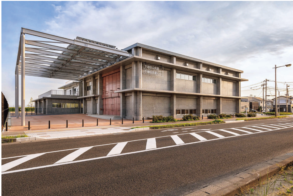
図 30 建物外観写真
