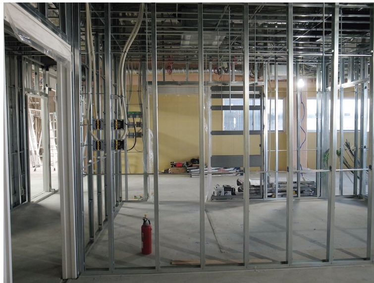
図 28 施工中の乾式壁
