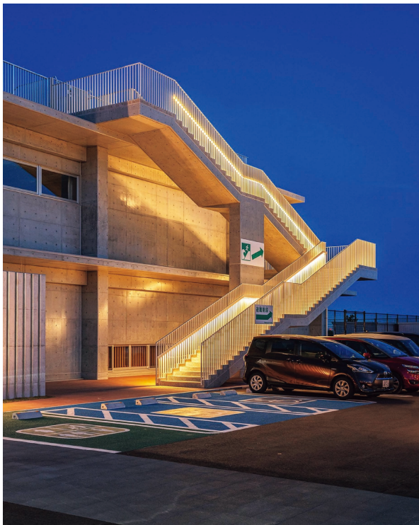
図26 駐車場から視認性のよい外部階段、津波避難ビルの掲示も設置
