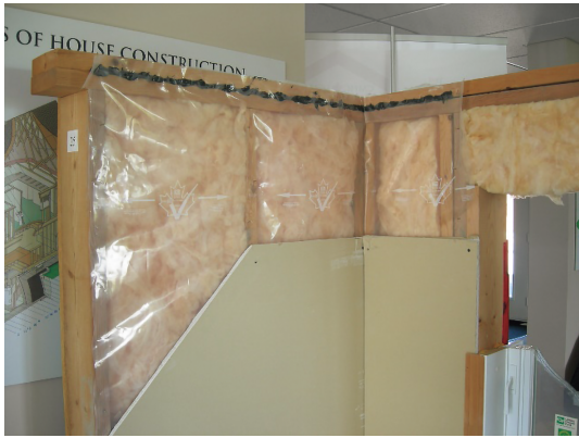
写真6 カナダにおける高断熱・高気密住宅のつくり
