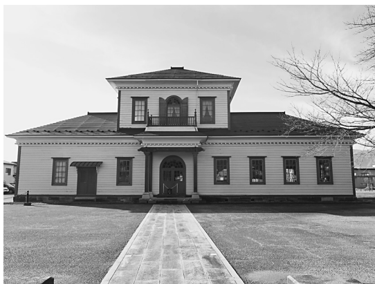
図3 旧西置賜郡役所（小桜館） (出所) 2020年11月19日、渡部撮影。
