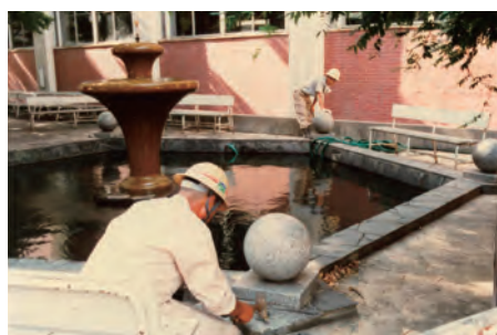
噴水池の解体作業
