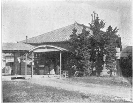
火災後の仮校舎
