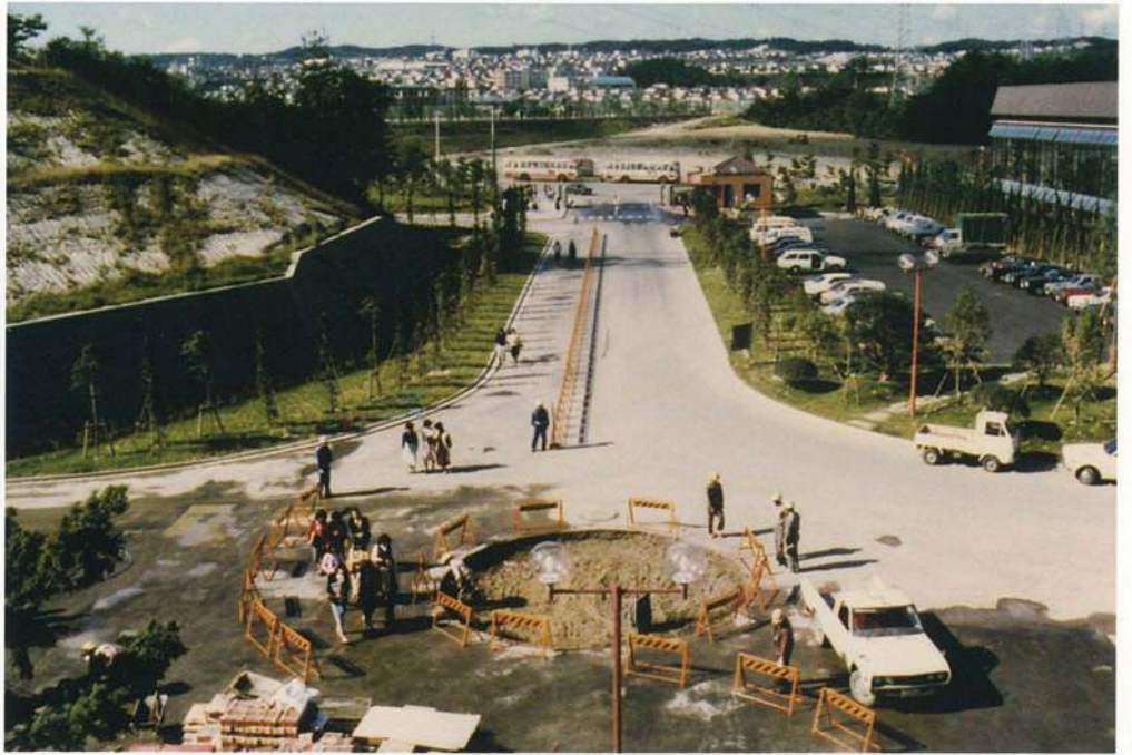
建設中のロータリー 1980(S55)10月
