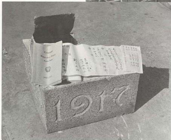
第二校舎解体工事により取り出された定礎石
