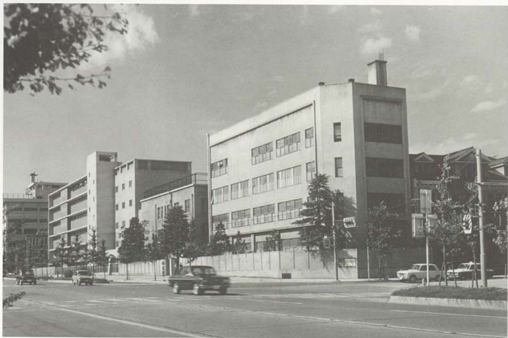
東二番丁通り拡幅のため解体し、第二校舎新館を建築 1958(S33)6月
