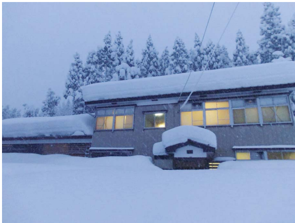
写真1 冬期の状況写真
