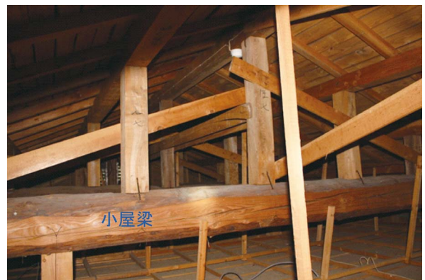
写真4 飛渡第一小学校 池谷分校屋根裏 (小屋組)の現状写真
