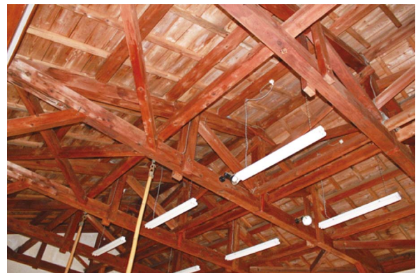
写真5 飛渡第一小学校 池谷分校体育館 (小屋組)の現状写真
