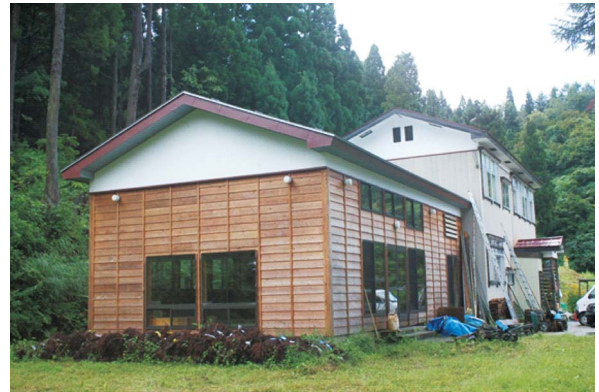
写真3 飛渡第一小学校 池谷分校体育館 (木造1階建)の現状 (集会施設) 写真
