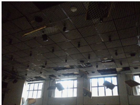
写真5 施設の被害：天井の落下
