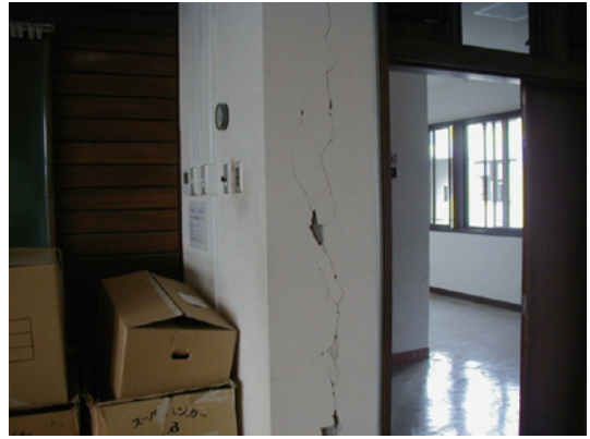
写真2 施設の被害：壁のひび割れ
