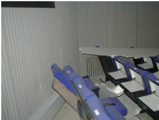
写真9 施設の被害：ハンセンホールの内壁落下
