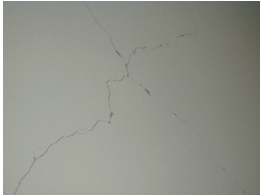
写真1 施設の被害：耐震壁のひび割れ
