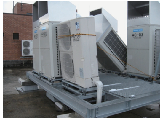
写真8 設備機器の被害：空調機器の転倒
