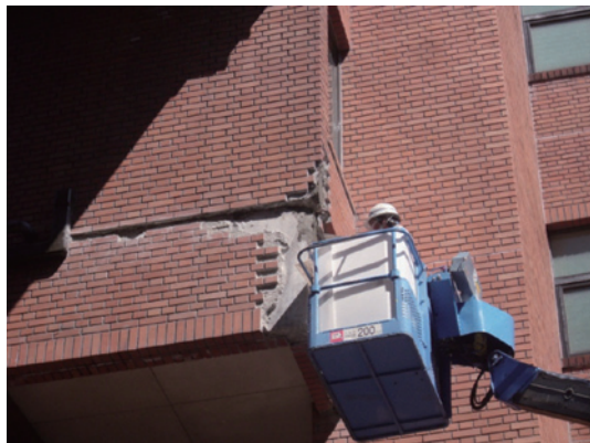
写真3 施設の被害：外壁の破損
