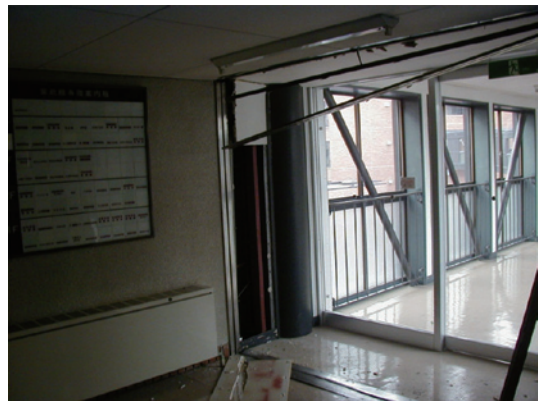
写真4 施設の被害：E X P. J の破損
