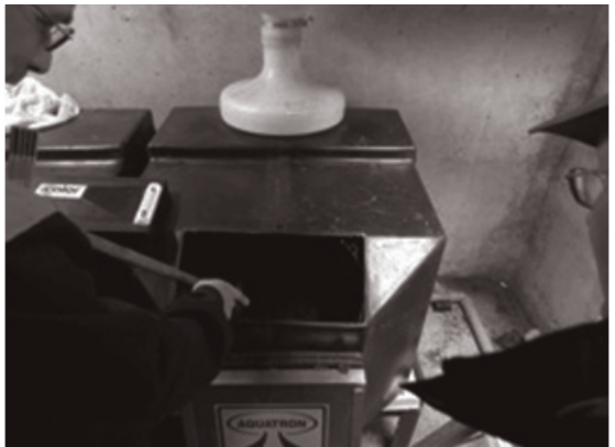
図 22 尿分離型トイレの処理システム。コンポスト内はミミズが快適な温度に調整される。
